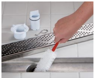
Reinigung des Ablaufs
