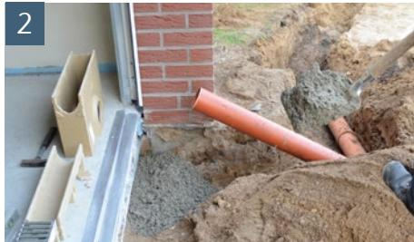
Einbringen des Streifenfundamentes gemäß Einbauempfehlung (siehe Punkt 1)
