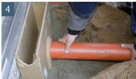
KG-Rohr mit Gleitmittel in den Einlaufkasten einsetzen. Das Ende des Rinnenstrangs und die andere offene Seite des Einlaufkastens mit einer Stirnwand verschließen. Optional: Geruchsverschluss verwenden.
