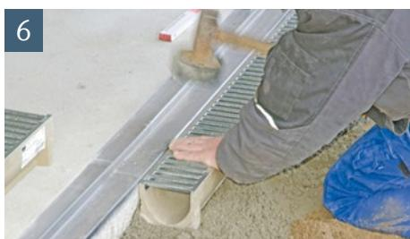
Ansetzen des Rinnenkörpers an den Einlaufkasten. Ausrichten des Rinnenstrangs. Die 2 cm Garagenschwelle ist so ausgeführt, dass das Tor zwischen Schelle und Rinne schließt.
