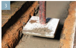
3 Den erdfeuchten Magerbeton in den Graben füllen und verdichten. Berücksichtigen Sie ggf. die Höhe des Auslaufelements sowie den für die Fertigstellung erforderlichen Abstand von 3-5 mm zwischen Rostoberkante und Oberflächenbelag.
