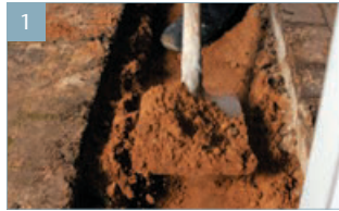
1 Graben für das Betonbett ausheben.
