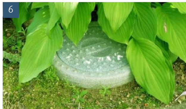
6 Wasseranschluss-Box einsetzen und mit KG Rohr DN 110 verbinden. Die Box hat einen 100 mm Anschluss. Achten Sie darauf, den Deckel bündig mit dem Boden einzusetzen
