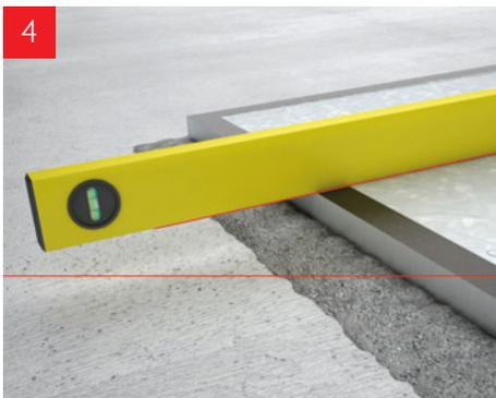
Gut eindrücken und zur Oberkante des Fußbodens eben ausrichten
