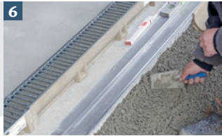
6 Losen Beton auf das bereits verdichtete Fundament aufbringen
