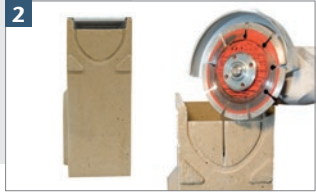
2 Zum Anschließen des Rinnenkörpers die Vorformung am Einlaufkasten mittels Winkelschleifer mit Diamantscheibe mittig einschneiden ...
