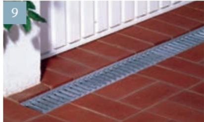
9 Den Oberflächenbelag an den Rinnenkörper anarbeiten. Achten Sie darauf, dass die Rostoberkante ca. 3-5 mm unter dem Oberflächenbelag liegt. Vor Belastung Beton aushärten lassen.
