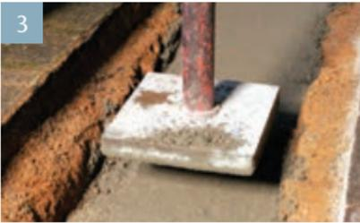
3 Den erdfeuchten Magerbeton in den Graben füllen und verdichten. Berücksichtigen Sie ggf. die Höhe des Auslaufelements sowie den für die Fertigstellung erforderlichen Abstand von 3-5 mm zwischen Rostoberkante und Oberflächenbelag.
