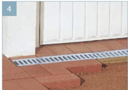
4. Rinnenkörper im Betonbett aneinandersetzen und ausrichten.
