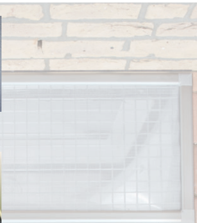
Die Bürstendichtung bildet einen sauberen Anschluss zur Wand
