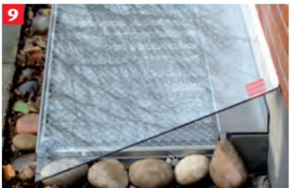
Während der Rückstapphase kann die Entwässerung von anfallendem Oberflächenwasser nicht erfolgen. Aus diesem Grund empfehlen wir den Einsatz der ACO Lichtschachtabdeckung. Wichtig für die Außengestaltung: Der angrenzende Oberflächenbelag am Lichtschacht muss so ausgebildet werden, dass kein Oberflächenwasser in den Lichtschacht laufen kann.
