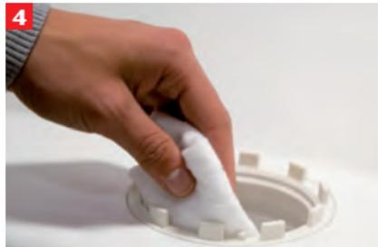
4 Innengewinde des Grundkörpers von Verschmutzung befreien. Nun können alle gesäuberten Elemente des Rückstauverschlusses wieder zusammengefügt werden
