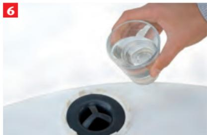
6 Anschließend den Geruchsverschluss in den Befestigungsring drücken und mit Wasser füllen. Danach den Laubfangkorb aufstecken und arretieren
