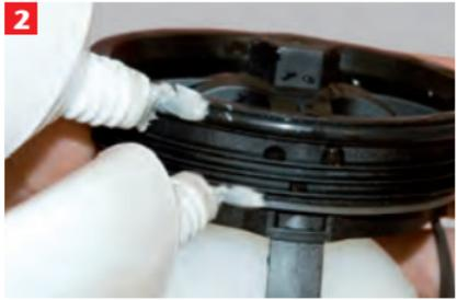
Die Rückstaeinheit kann separat bestellt werden. Beim Rückstauerchluss ist sie im Lieferumfang enthalten. Vor dem Einsetzen den O-Ring und die Dichtlippe dünn mit Gleitmittel bestreichen
