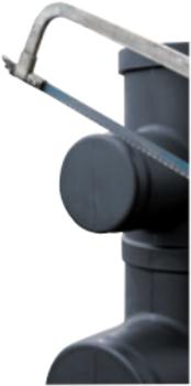
Vor dem Ansetzen des Geruchsverschlusses oberen und unteren Anschlussstützen am Ablaufschacht öffnen.
